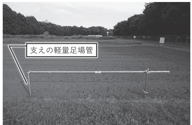
図11. 倒したマストを支える軽量足場管をマスト先端に取り付けた様子.
