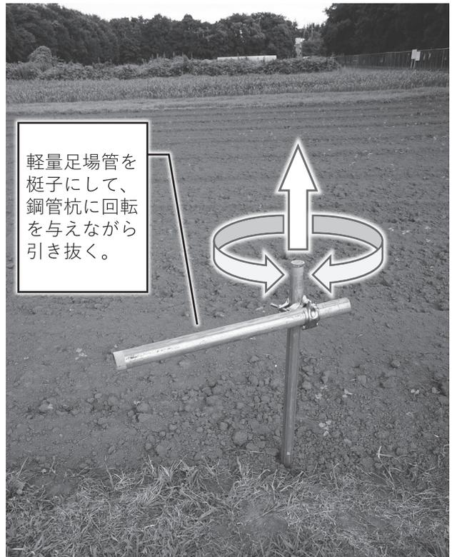
図13. 杭の抜き方。
